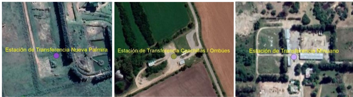
Figura 45: Detalle de las Estaciones de Transferencia . Departamento de Colonia
